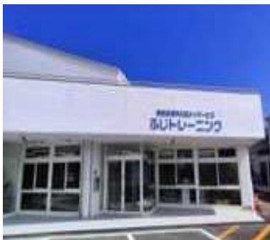
ふじトレーニングの建屋外観
