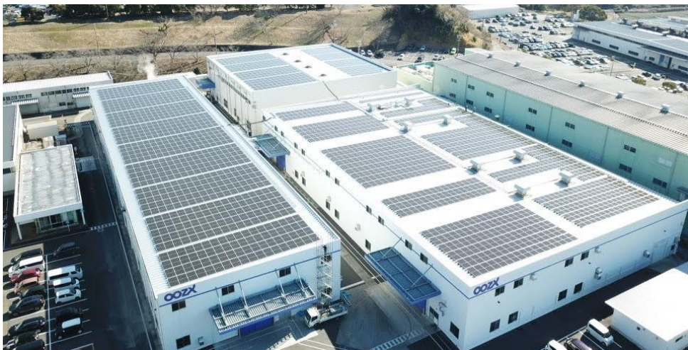
静岡工場の太陽光発電パネル
